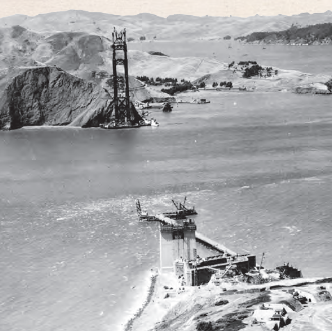
Construcción del puente Golden Gate, 1933.
