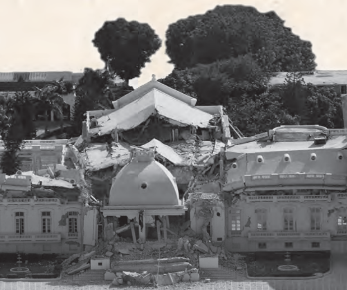
Palacio Presidencial de Haití severamente dañado por sismo, Puerto Príncipe, Haití, 13 de enero de 2010.
