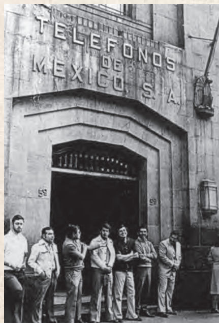
Trabajadores de Teléfonos de México a las afueras del edificio principal luego de la requisición, 11 de marzo de 1982.
