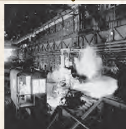
Al interior de la siderúrgica, 1969.
