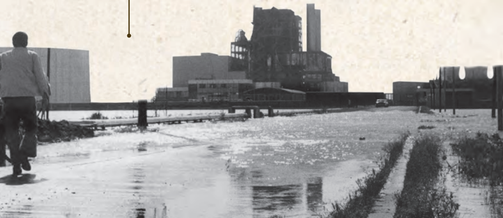
Planta generadora de energía eléctrica que la Comisión Federal de Electricidad instaló en Salamanca, Guanajuato.
