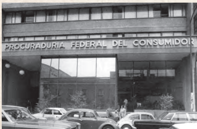
Primeras Instalaciones del edificio de la Procuraduría Federal del Consumidor.
