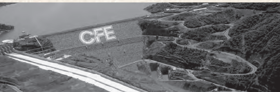
Hidroeléctrica El Cajón, en Guerrero, ICA.
